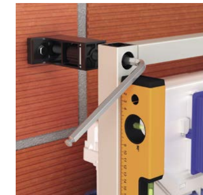
2 Прикрепите инсталляцию к полу и стене и отрегулируйте настенные крепежные скобы EasyFix™, убедившись, что инсталляция выровнена по уровню со стеной.
