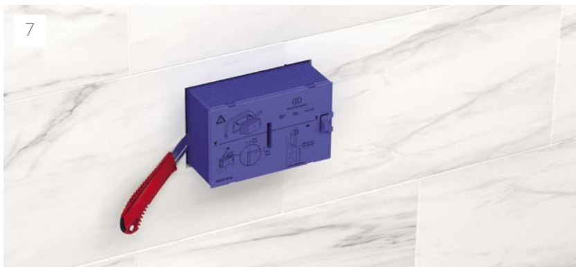
7 Отрежьте короб сервисного окна заподлицо с чистовой стеной.
