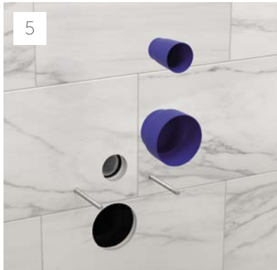
5 Удалите и отдайте в переработку защитные короба, а также обрежьте смывные и сливные трубки до нужной длины, учитывая глубину отверстий в стене и унитазе.
